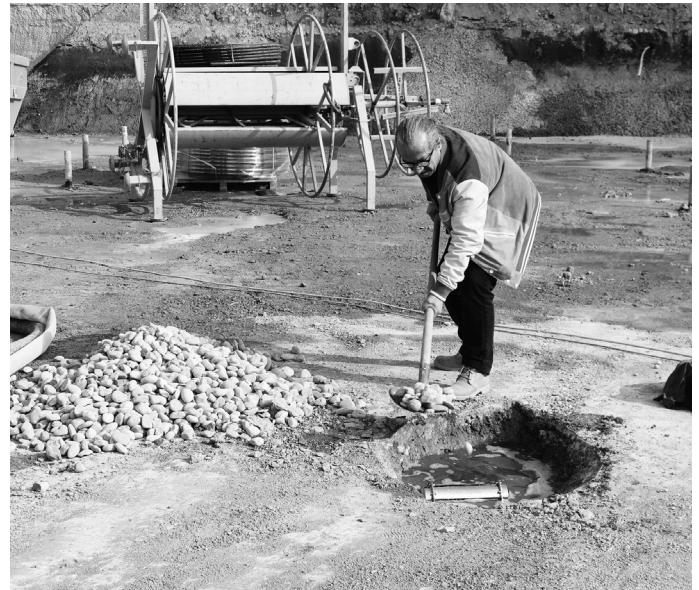
Der Grundstein wird von Bauleiter Giovanni Giulivi mit Steinen zugeschüttet.
