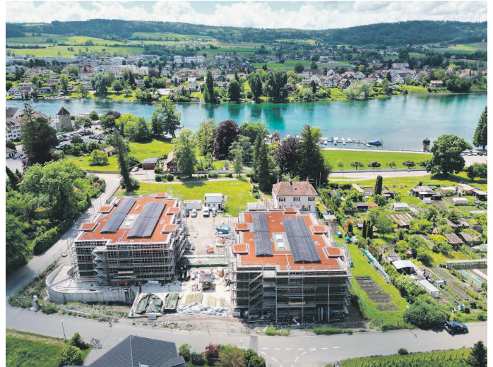
Die in Bau befindlichen Alterswohnungen in Stein am Rhein mit Fotovoltaik-Anlagen.
